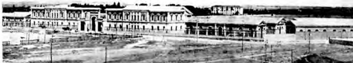
Prospetto principale del grandioso Stabimento Ippico di Foggia, inaugurato nel 1931.
