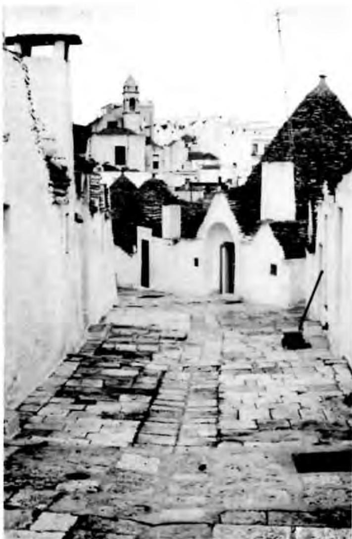
La stessa veduta oggi. Si confronti la prima casella a sinistra con quella della foto di Alinari. Il comignolo, costruito negli anni Cinquanta, ha solo una funzione scenografica, poiché non è collegato al vano, oggi usato come servizio igienico. (foto Angelo Ambrosi)
