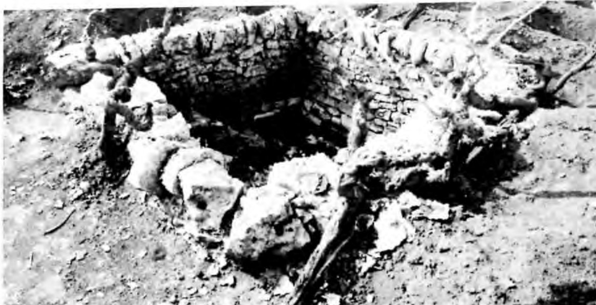
Cavaggiòne in muratura a secco per il contenimento del terreno trasportato dal ruscellamento superficiale dopo la zappatura o la sarchiatura. (foto Riccardo Ippolito)
